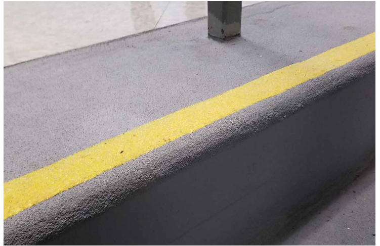
投入使用一年以上的贝尔佐纳 (Belzona) 4411 特写图
