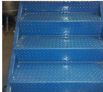
施工前的金属楼梯
