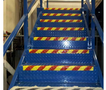
施工后的金属楼梯
