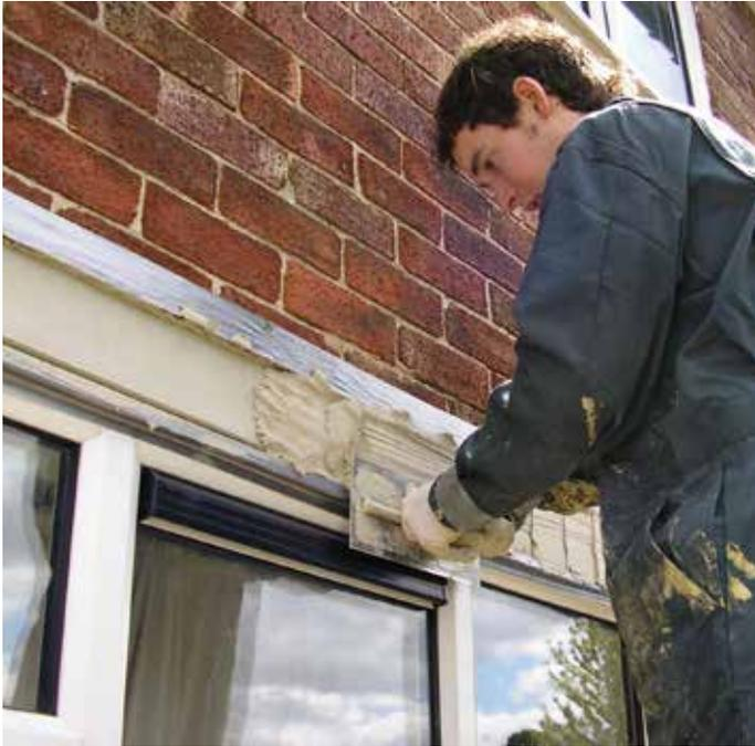
贝尔佐纳(Belzona) 4141(乳浆建造)是一种双组分、轻质修复复合材料,适用于修复受损的立面和顶面混凝土表面。这一厚浆型涂层系统可简化施工,同时提供持久保护。
